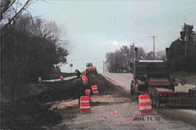
20191119KKJ Mini excavator arrives .JPG
